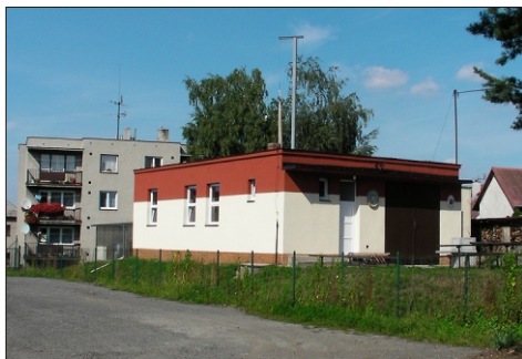
Nová výměnná okna a opravená fasáda hasičárny.
